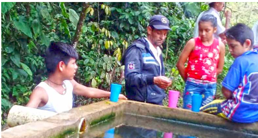
Aletones. Minga en acueducto comunitario de la vereda Aletones del municipio Belén de Los Anadaquies. Foto Maya Pinzón
