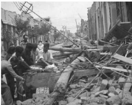
Foto N° 3. Sobrevivientes removiendo escombros. Fuente: AGN, 1944.
