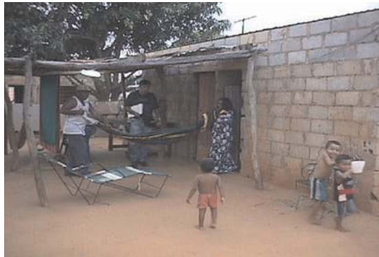
Figura 6. Configuración espacial del modelo viejo : un recinto a media agua y la luma o enramada adosada.
