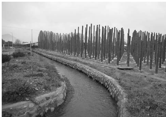
Imagen 3: Memorial de Paine en etapa de construcción.
