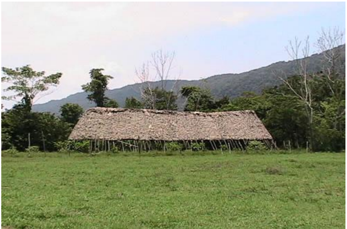
Foto 12. Nuevas formas constructivas de la Soáikái. Fuente: ASOCBARI
