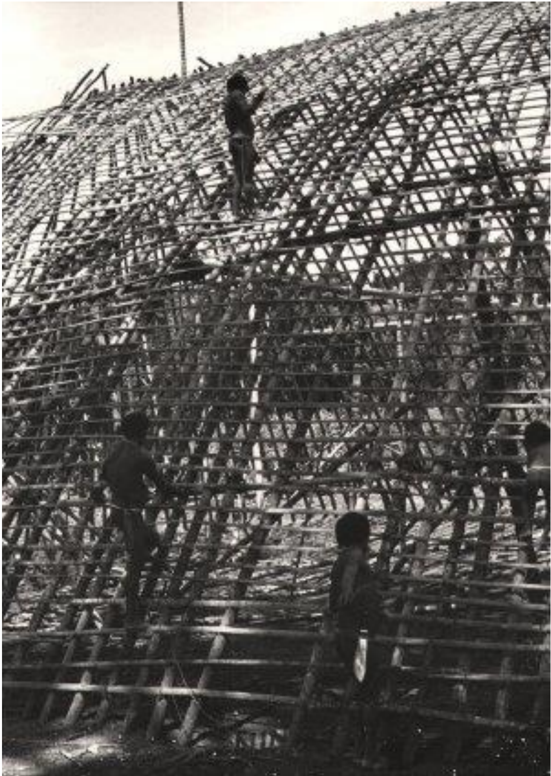
Foto 4. Construcción de la Soáikái. Amarres transversales Fuente: ASOCBARI
