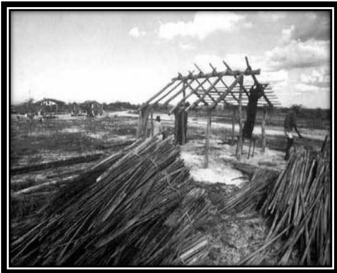
Fig. 66: Construcción de vivienda tradicional wayuu
